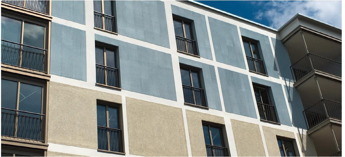
NB Wohnüberbauung in Dietlikon, Objektgrösse 9000 m<sup>2</sup>. **Systemaufbau:** Dämmung mit EPS und Steinwolle, 200 mm, Grundbeschichtung PURA Einbettmörtel 426, Netzeinbettung PURA Einbettmörtel 426, Deckbeschichtung PURA Edelputz 402 Vollabrieb, 5.0 /2.0 /1.0 mm, Anstrich PURA Silikatfarbe 2K.
