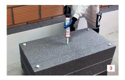
Um die Nachexpansion zu minimieren, kann ca. 5 cm vom Eckbereich und in der Plattenmitte ein etwa walnussgrosser Klebepunkt mit der Polymer Klebemasse aufgetragen werden.
