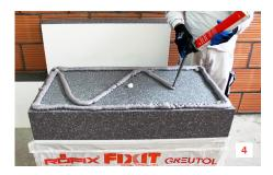
Den PU-Klebeschaum umlaufend mit gleichmässigem Wulst (ca. 3 cm breit und 1 cm hoch) randnah und in Form eines geschlossenen «W» oder «M» auftragen.
