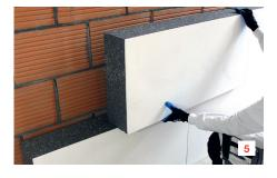
Die Dämmplatten werden dicht im Verband gestossen. Die Dämmplatten in der gewünschte Position andrücken.
