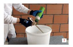
Durch das mit der Stellschraube geschlossene System können neu aufgeschraubte PU-Klebeschaumdosen auf der Pistole belassen werden. Zum Reinigen der Pistole ist der PU-Pistolenreiniger aufzuschrauben und durchzuspülen.
