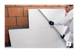
Wenn nötig, können die Dämmplatten nach ca. 10–15 Minuten mit einer Richtlatte nachgedrückt werden.
