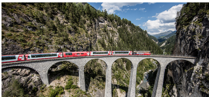
Viaductul Landwasser, Calea Ferată Retică, Elveția
