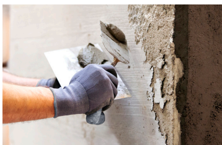
Sisteme de renovare și asanare
