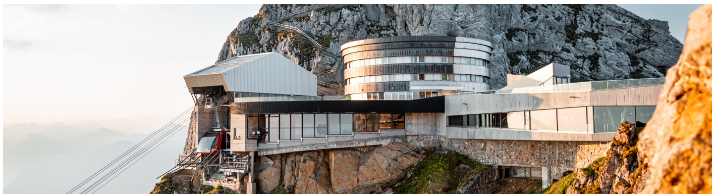
Extinderea sălii de așteptare, stația montană Pilatus Kulm, Elveția
