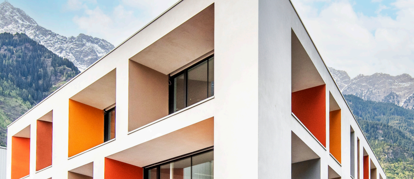
Fațada sediului RÖFIX Partschins. Italia
