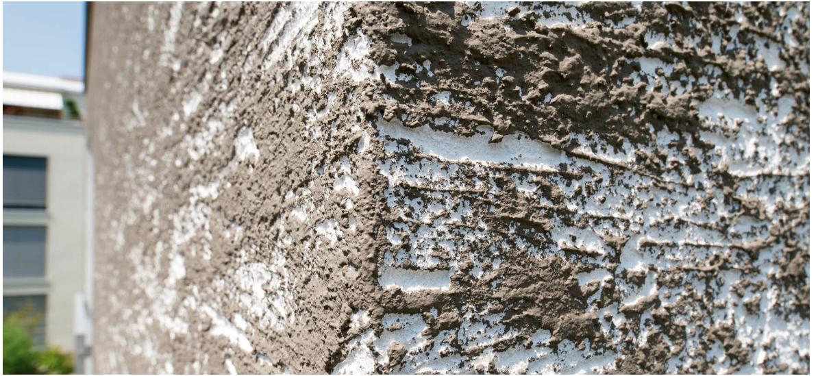
Mehrfamiliengebäude in Oberwil, Objektgrösse 360 m 2 . Systemaufbau: Dämmung mit EPS Lambda White 031, 160 mm, Netzeinbettung Greutol Combi-Putz 488, Deckbeschichtung Greutol Deckputz aussen Vollabrieb Universal Rillenstruktur 5.0 mm, Anstrich GreoColor OptiTop.
