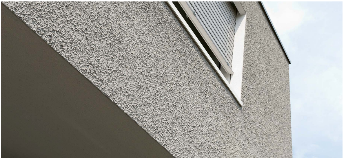
Zweifamilienhaus in Fislisbach, Objektgrösse 370 m 2 . Systemaufbau: Dämmung mit EPS Lambda Plus 180 mm, Grundbeschichtung Greutol Einbettmörtel light 425, Netzeinbettung Greutol Multimörtel 406, Deckbeschichtung Greutol Kellenwurf 300, 6.0 mm, Anstrich GreoColor OptiTop.
