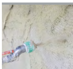
3 Nanošenje termoizolacionog maltera
