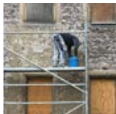
2 Moguće pripremne mere poput nanosa šprica i/ili nosača maltera i sl.
