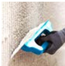
5 Izvođenje armirajućeg sloja sa odgovarajućim malterom i mrežicom
