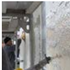
6 Nanošenje završnog maltera
