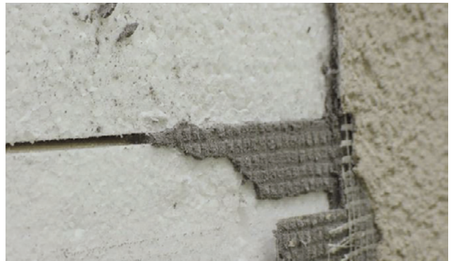
Disposition imbriquée à l'angle du bâtiment
