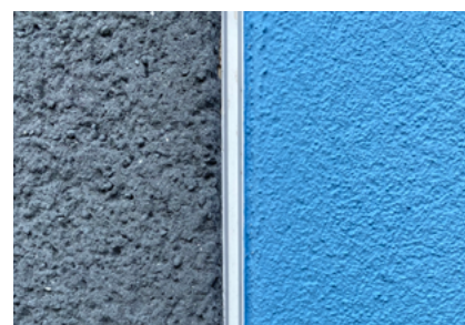
Profilé pour joints de dilatation en PVC
