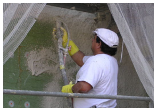
Construction avec panneaux en laine de pierre
