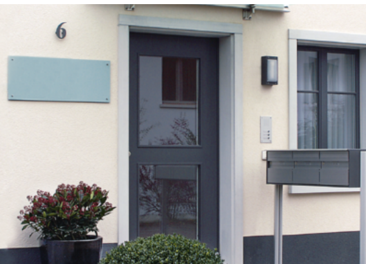
Exemples de charges légères sur l'isolation extérieure
