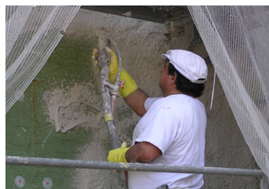
Construction avec panneaux en laine de pierre
