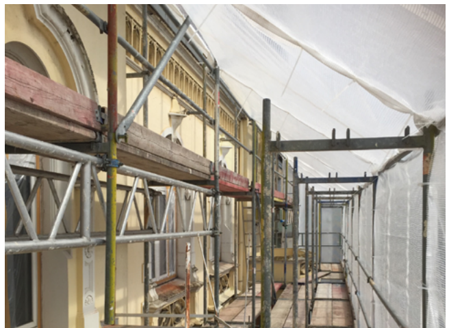
Echafaudage avec toit de protection contre la pluie
