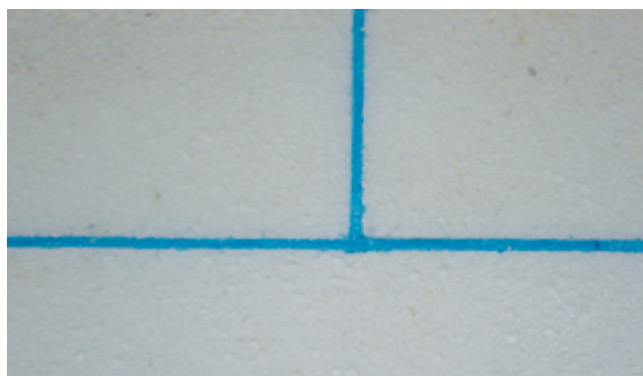
Remplir les joints ouverts avec des bardeaux XPS ou Cales en mousse dure EPS
