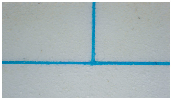
Remplir les joints ouverts avec des bardeaux XPS ou Cales en mousse dure EPS
