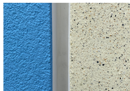
Profilé pour joint de dilatation
