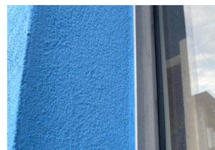
Raccord de fenêtre avec profilé de raccordement Ideal Plus en blanc ou anthracite
