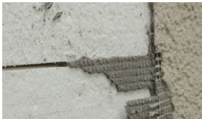
Disposition imbriquée à l'angle du bâtiment
