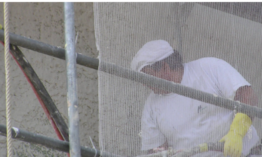
Bâtiment protégé contre la pluie et des températures basses
