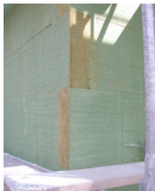
Disposition imbriquée à l'angle du bâtiment
