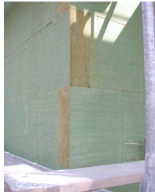
Disposition imbriquée à l'angle du bâtiment
