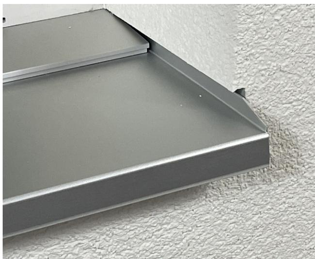
Mit dem Einbau des Sol Pad Fenstersystems lässt sich ein unterhaltsfreundlicher Anschluss zwischen Fensterbank und Fassade realisieren. Durch die Entkoppelung von Fassade und Fensterbank entsteht ein wartungsfreier und schlagregensicherer seitlicher Anschluss. Thermisch bedingte Längenänderungen der Fensterbänke werden durch die Entkoppelung problemlos und dauerhaft aufgenommen.
