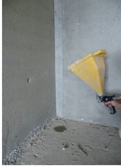
Projeté avec un pistolet à entonnoir
