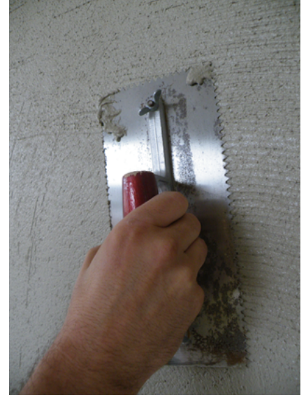
Rayer avec une truelle dentelée
