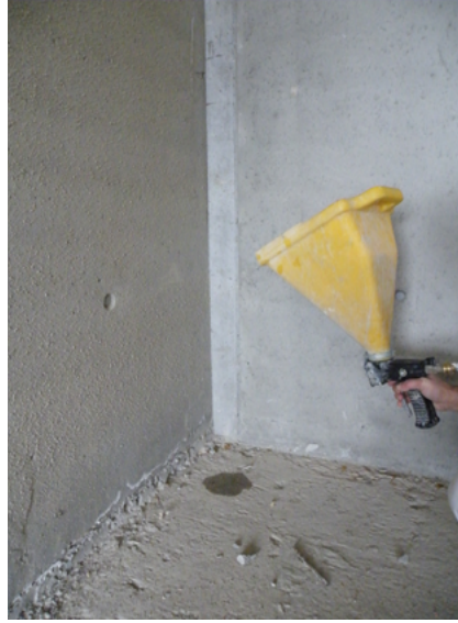
Projeté avec un pistolet à entonnoir
