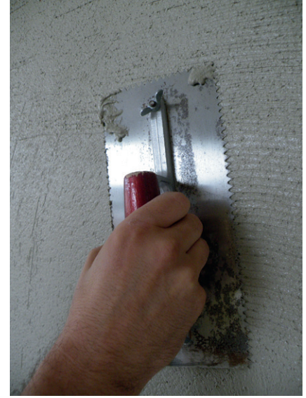
Rayer avec une truelle dentelée
