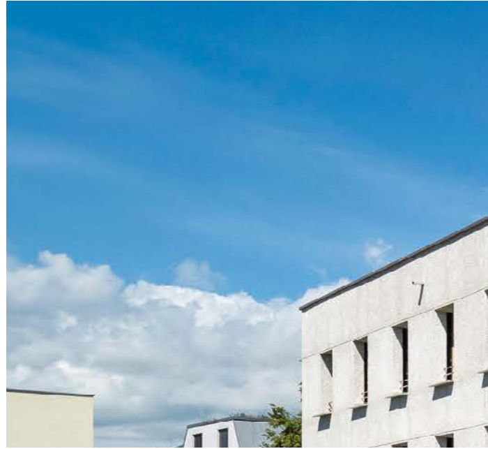
OPENLY Valley „Hanfhaus“, Widnau, Švicarska
