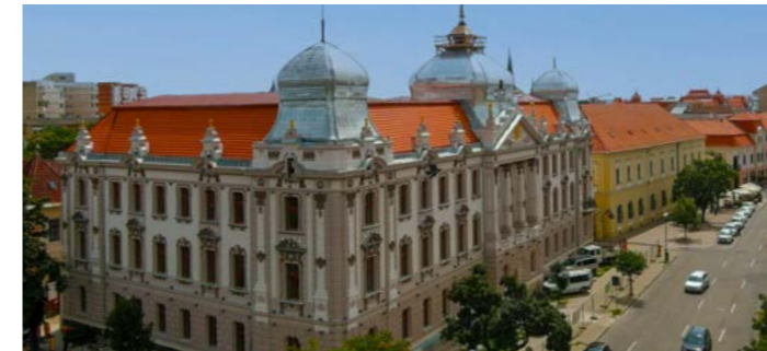
Zgrada vlade u Oradei, Bihor, Rumunjska
