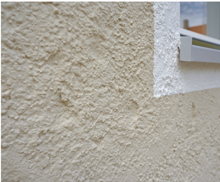
Außenfassade mit Nischen und aufgeputzten Faschen
