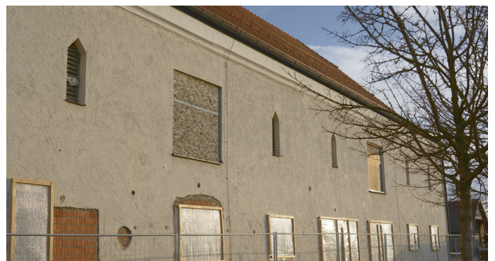
Das alte Stallgebäude der Stiftung Ecksberg vor der Sanierung (2019).
