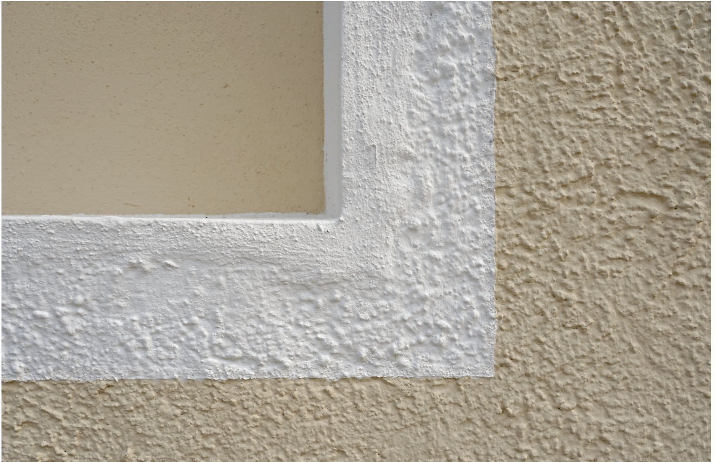
Außenfassade mit Nischen und aufgeputzten Faschen
