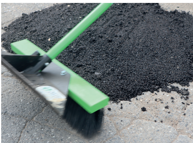
Pulizia e finitura del prodotto mediante scopa.
