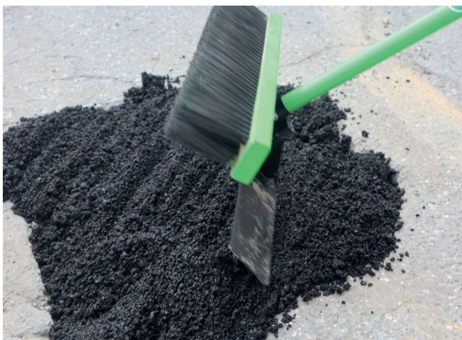
Distribuzione, mediante rastrello o apposito attrezzo, del materiale in modo omogeneo e planare, in uno spessore minimo di 2 cm.
