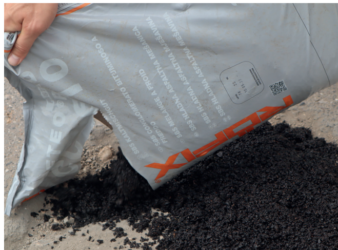
Il prodotto è pronto all'uso. Aprire la confezione e applicare direttamente sul supporto.
