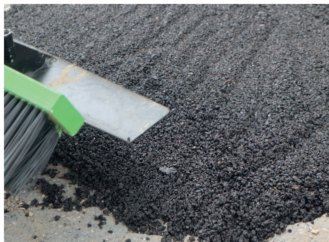
Costipazione e battitura del prodotto sul supporto in modo da renderlo adeso, stabile e compatto.
