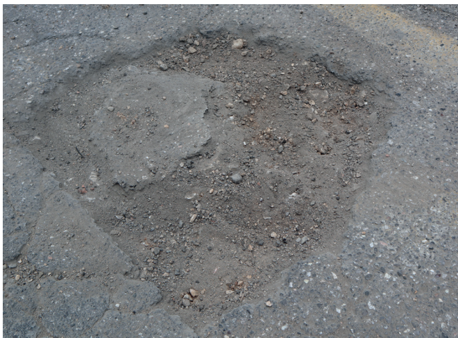
Il supporto dovrà essere sommariamente pulito, privo di parti decoese od in fase di distacco.
