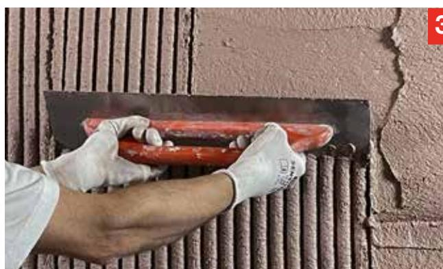
3. Le lendemain, appliquer manuellement ou mécaniquement l'enduit de finition minéral Greutol Enduit gratté 793 (granulométrie : 2 mm). Avec la truelle dentée R16, peigner l'enduit de manière régulière dans une direction, avec un angle de 45°.
