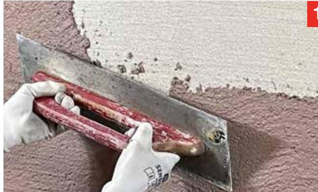
1. Sur la couche d'armature rendue rugueuse horizontalement, appliquer l'enduit de finition minéral Greutol Enduit gratté 793 (granulométrie : 2 mm) avec une épaisseur de grain.
