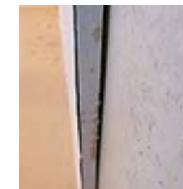
Plattensanierung mit Hohlräumen
