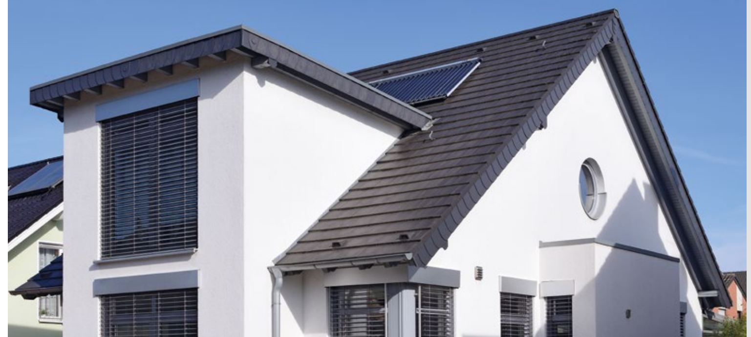
Ober- und Deckputze
