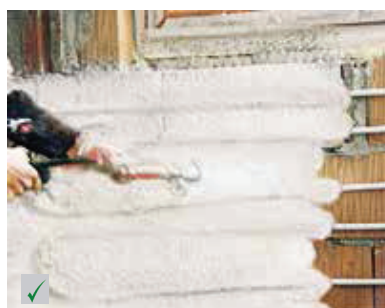
Incorporazione del riscaldamento a parete nell'intonaco RÖFIX Renoplus
