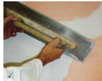
Strato di armatura in caso di supporti problematici RÖFIX Renostar® , RÖFIX Renoplus®
