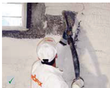
Livellamento del supporto prima del rivestimento definitivo (nuova pittura, rivestimento murale) RÖFIX Renoplus
