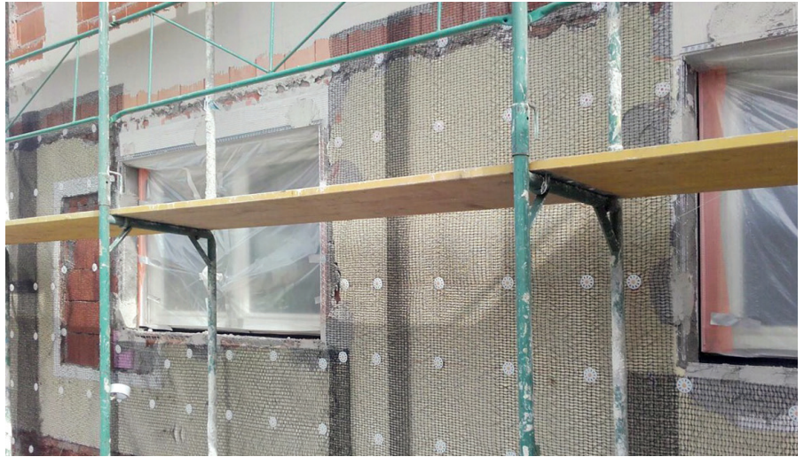
Esecuzione del foro e inserimento del tassello
