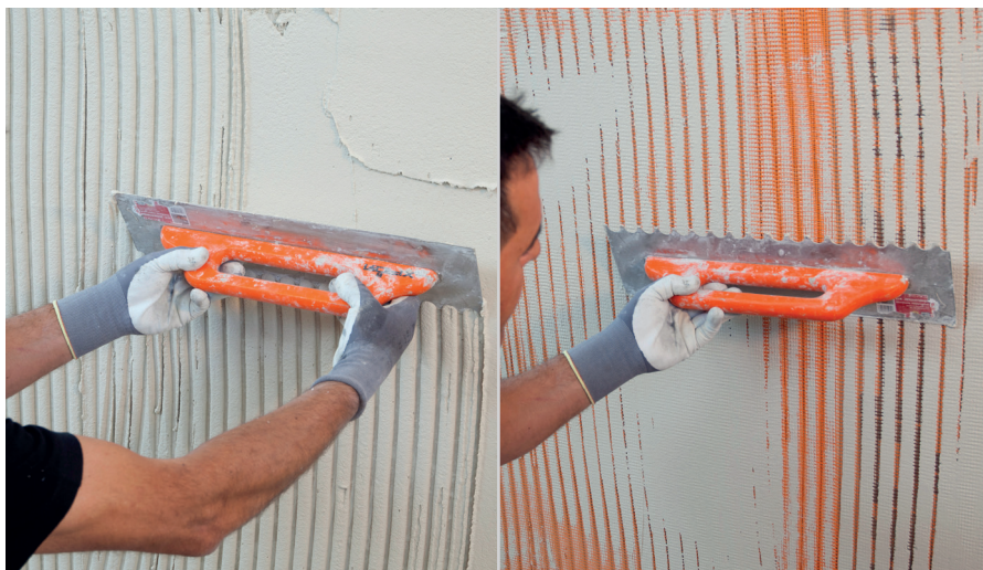
Applicazione della rasatura
