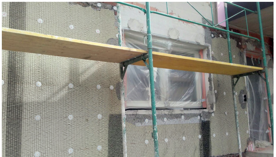
Listelli di battuta sugli spigoli di finestre
