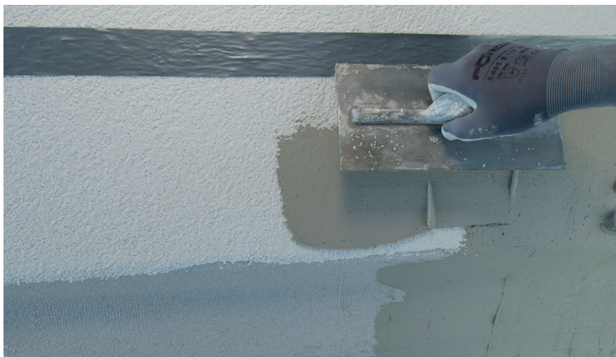
Impermeabilizzazione zoccolatura controterra
