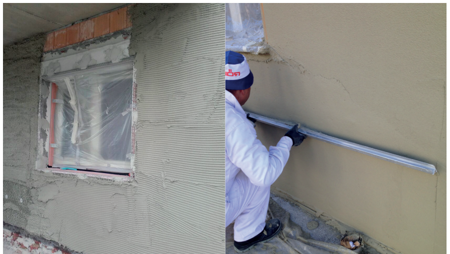
Applicare l'intonaco a macchina
