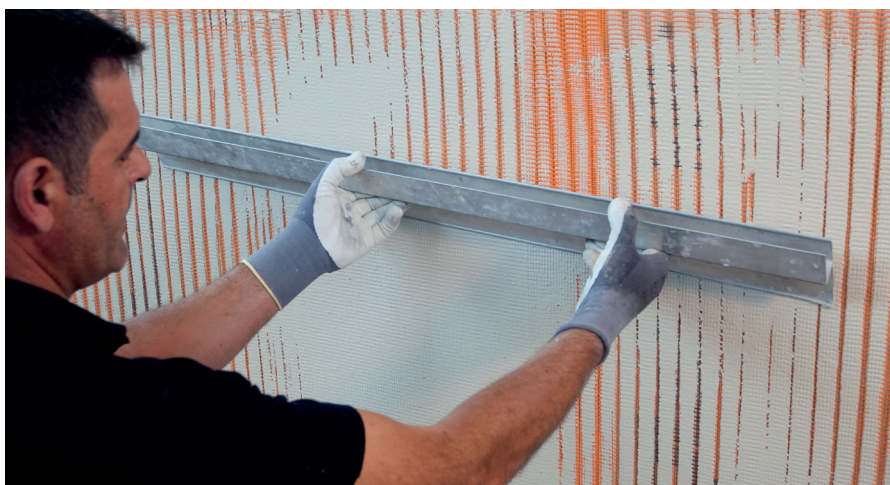
Livellamento della rasatura
