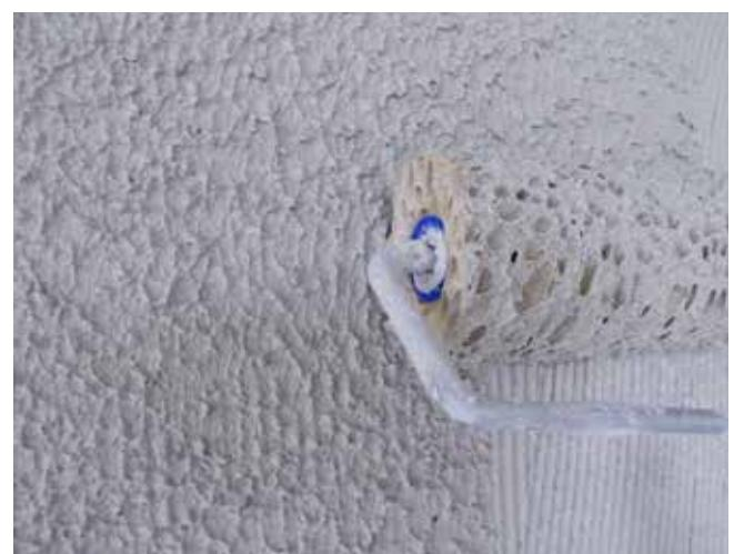
Remarque: maçonnerie pénétrée d'humidité et atteinte par les sels – voir info technique sur **L'assainissement de maçonneries atteintes de sels nuisibles**
