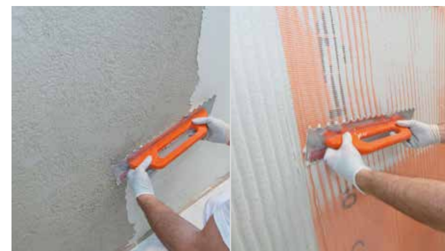
Armaturni sloj s RÖFIX Renoplus®-om i umetnutom RÖFIX P50
