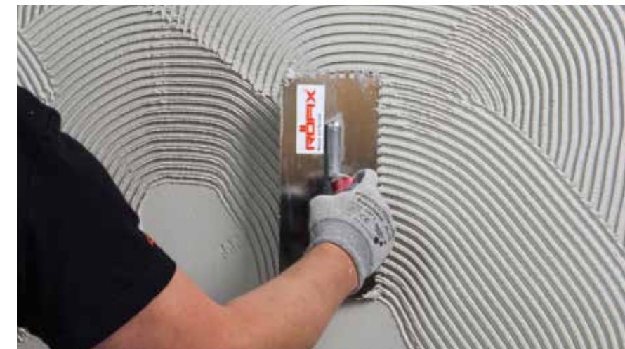
Češljanje RÖFIX SismaCalce® podložne žbuke
