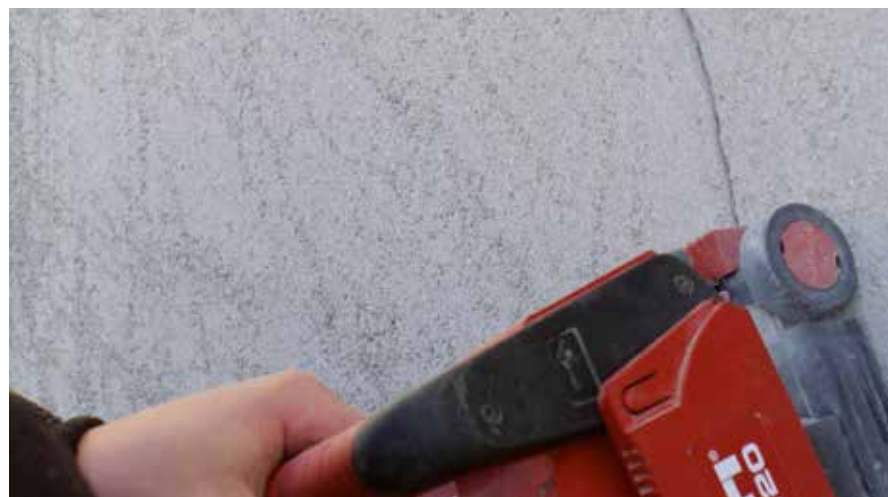
Izdublivanje konstrukcijskih/statičkih pukotina
