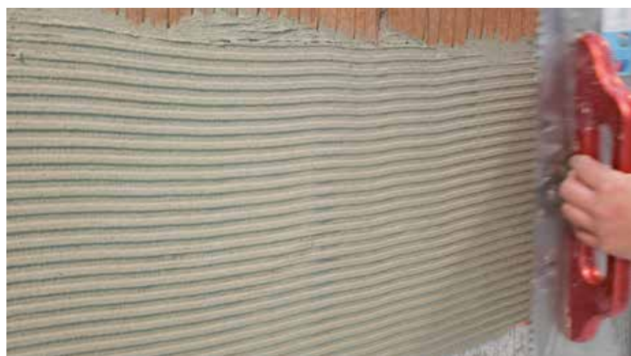
Osiguranje premoštavanja prijelaza beton-opeka
