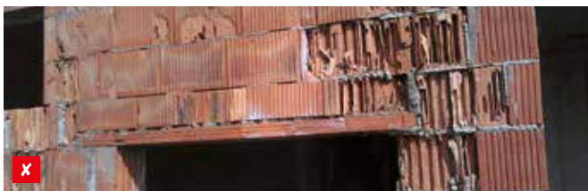
Schadhaftes Ziegelmauerwerk
