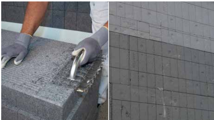
Na zunanjih vogalih zgradbe obrusimo nazobčano take-it strukturo
