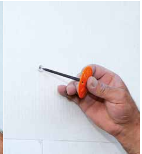
Pritrdimo z žebeljem RÖFIX NDF in pritrdilno podložko RÖFIX BTH
