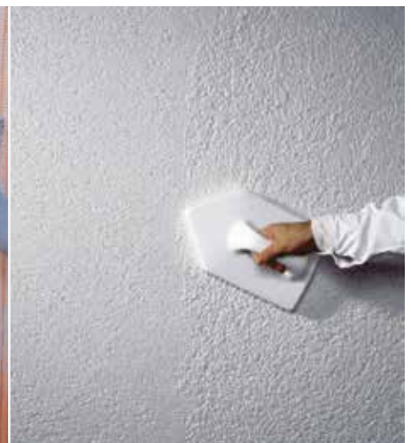
Na posušeni osnovni omet nanesemo zaključni omet in ga strukturiramo
