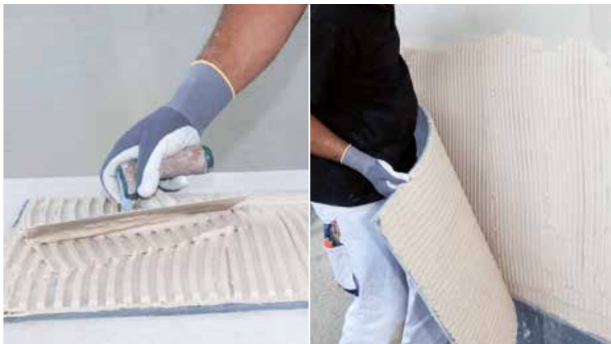
Lepilo vmasiramo v izolacijsko ploščo in nazobčamo, lepilo nanesemo tudi na podlago in izolacijsko ploščo nato dobro pritisnemo ob podlago
