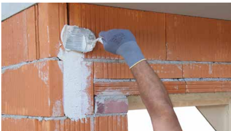
Vrzeli in luknje zapremo z maso RÖFIX 510 ali RÖFIX Renoplus®
