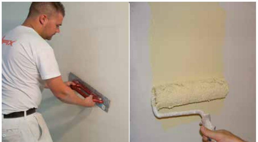
Nanašanje zaključnega ometa z jekleno gladilko
