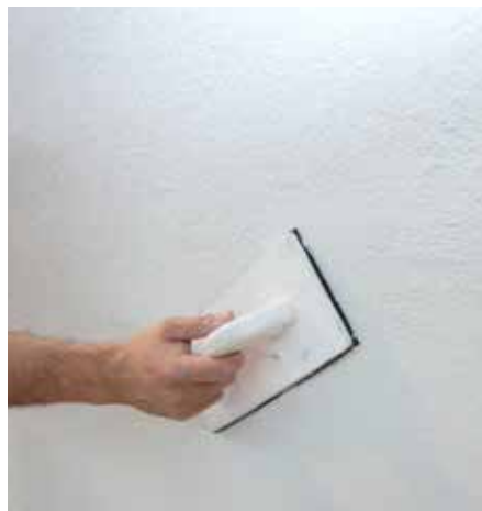
Strukturiranje z RÖFIX Renopor® Specialno lepilno maso
