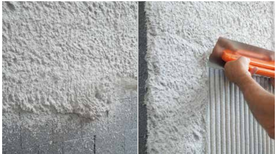
Osnovni omet nabrizgamo, ga razvlečemo, in enakomerno nazobčamo
