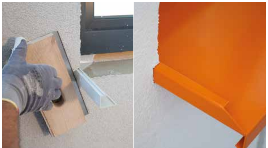
S pripomočkom RÖFIX SOL-PAD- Tool odrežemo tesnilno letev RÖFIX SOL-PAD z 2 mm nadmere in montiramo zaključno okensko polico
