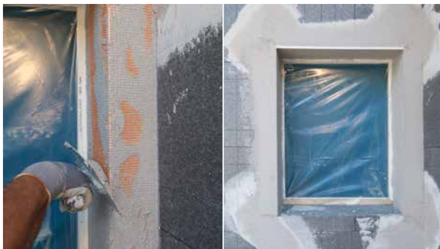
V polnoplaskovno nanosen omet vstavimo mrežne vogalnike sveže v sveže
