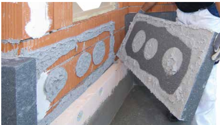
40-odstotna kontaktna lepilna površina
