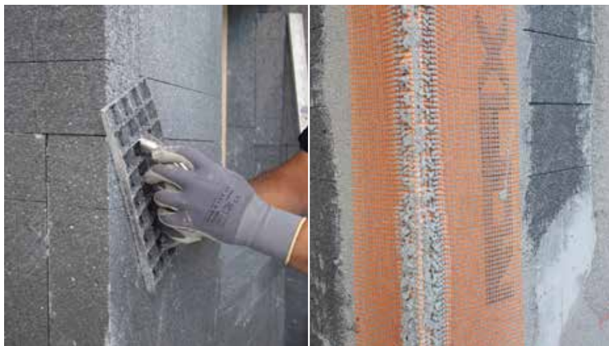
Obrusimo štrleče robove plošč
