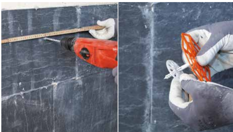
Pritrdila razporedimo v rastru 40x40 cm in montiramo po priloženih navodilih
