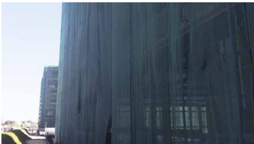
Fasadna zaščitna mreža štiti sveže vgrajene materiale pred zunanjimi vplivi in prehitrim izsuševanjem
