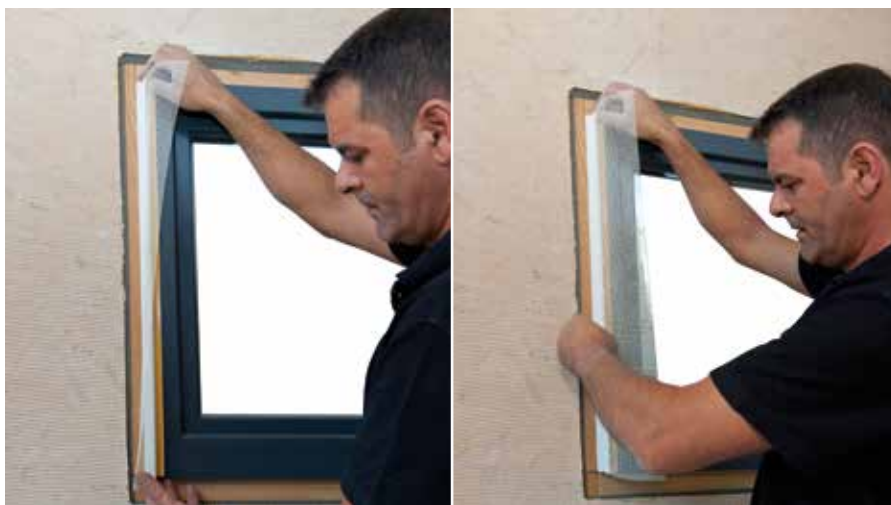
Profil pritrdimo pod pravim kotom na alu okvir in ga prilepimo na spodaj ležeči leseni okvir
