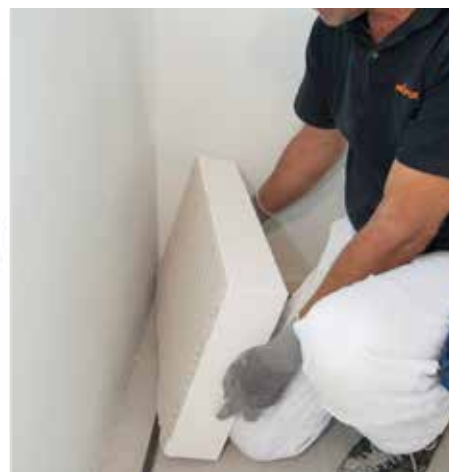
Pri polaganju vsako izolacijsko ploščo dobro pritisnemo
