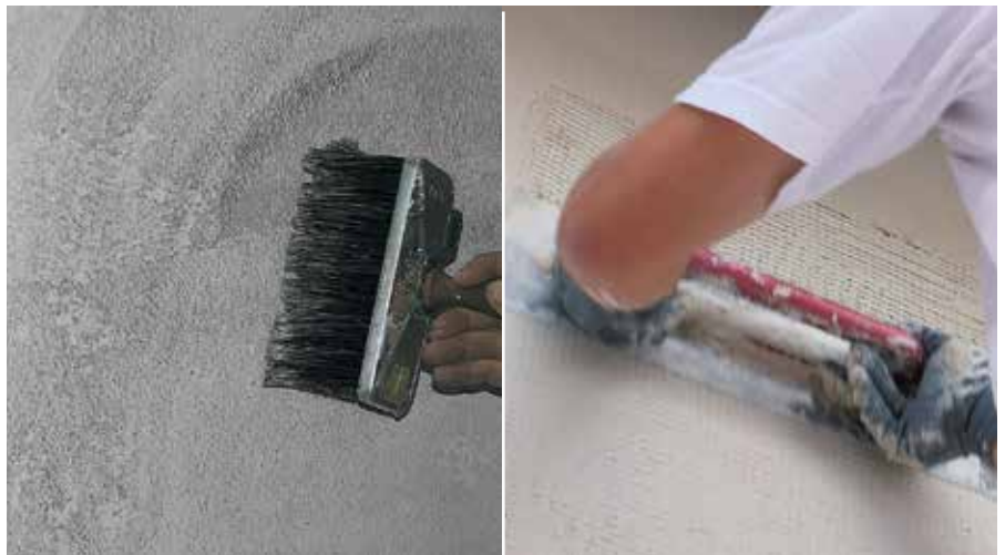
Utrditev površine s proizvodom RÖFIX PP 201
