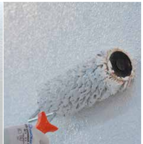
Premaz s paroprepustno barvo
