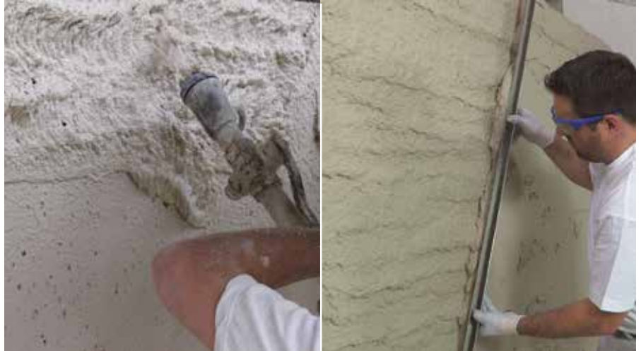
Nanašanje in porezovanje FIXIT 222 Aerogel Visoko izolativnega ometa
