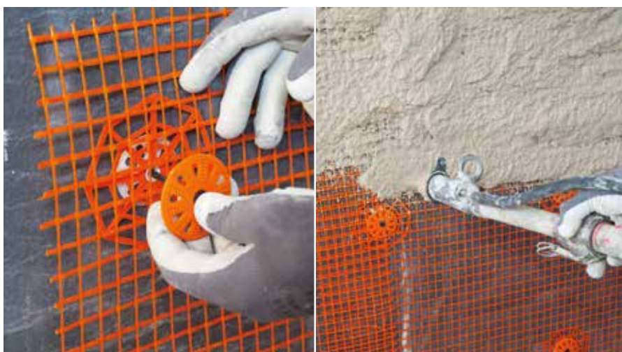
RÖFIX AR-oporno mrežico fiksiramo s pritrdilnimi podložkami RÖFIX BTH in žebeljnimi pritrdili RÖFIX NDF ter utrdimo z najmanj 10 mm ometa RÖFIX AeroCalce® IA 784 PLUS
