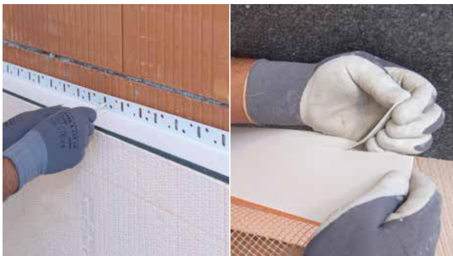
RÖFIX Osnovni profil podzidka pritrdimo profila
