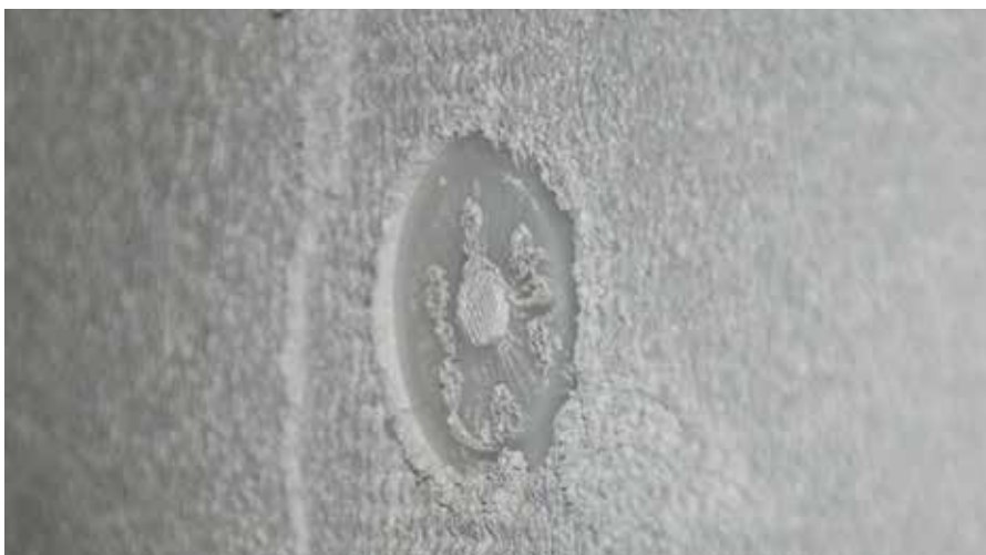
Pritrjujemo skozi sveži armirani osnovni omet
