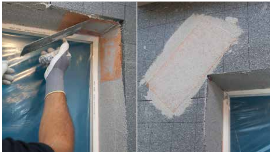
RÖFIX P50 Armirno mrežico vstavimo v sveži osnovni omet
