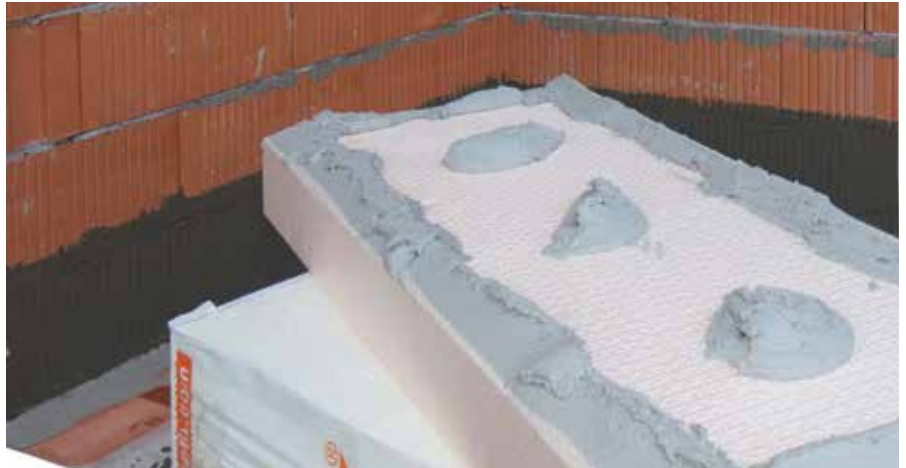
RÖFIX EPS-P 035 Izolacijske plošče za podzidek lepimo z 1- ali 2-komponentno maso RÖFIX OPTIFLEX® po pasovno-točkovni metodi
