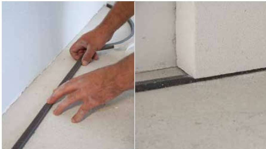
Notranji izolacijski sistem zrakotesno zapremo na stiku s tlemi, steno in stropom z RÖFIX Tesnilnim trakom za fuge
