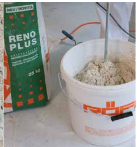
Izravnamo z ometom RÖFIX Renoplus®
