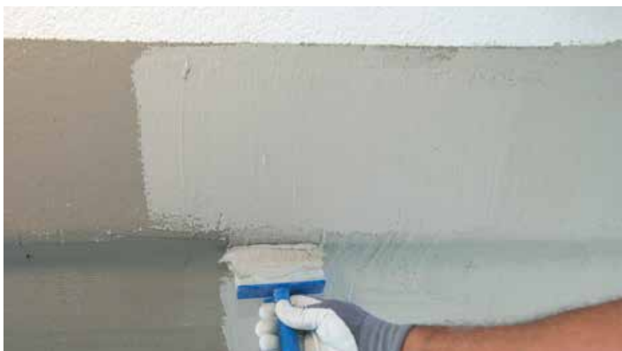
V 2. nanosu lahko RÖFIX OPTIFLEX® 1K ali 2K naneseš v redkejši konsistenci
