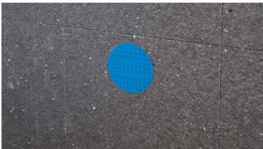
Prilepljena DoRondo PE Montažna rondela
