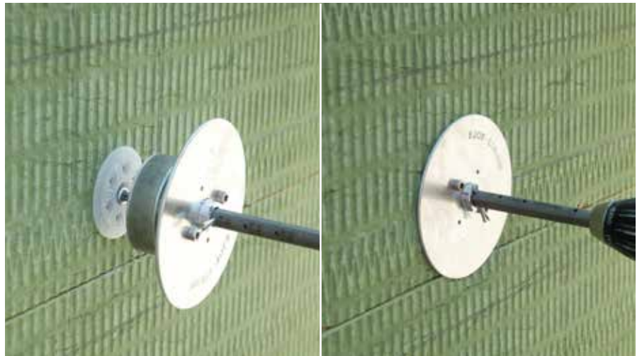
Z orodjem RÖFIX STR- Tool 2G poglobimo pritrdilo do naslona
