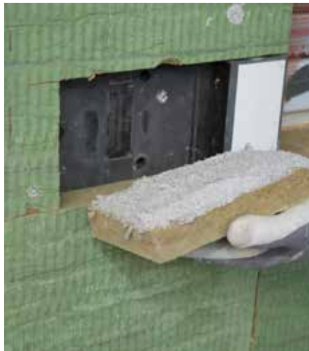
Na pritrdila prilepimo pokrivno izolacijsko ploščo
