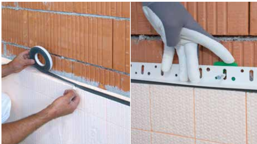
Tesnilni trak za fuge prilepimo na izolacijsko ploščo podzidka | Z distančniki izravnamo neravnine
