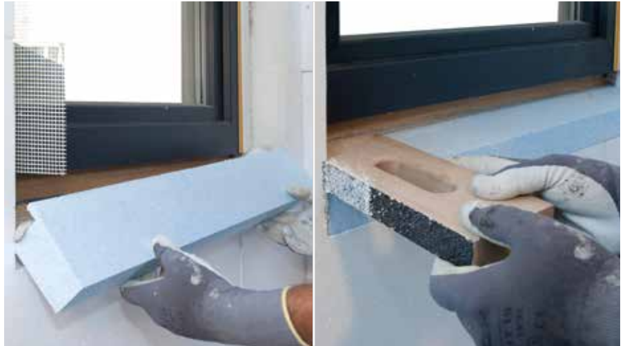
Prilepimo podložno ploščo RÖFIX SOL-PAD Base in vrežemo utor za montažo profila
