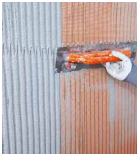
Armirani osnovni omet nanesemo v NDN 5 mm
