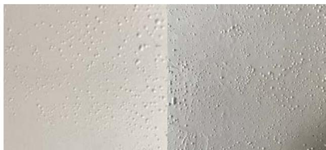
Wenn kaum Blasen sichtbar sind, kann der Untergrund direkt mit einem Fixit Produkt mit integrierter Haftbrücke beschichtet werden.
