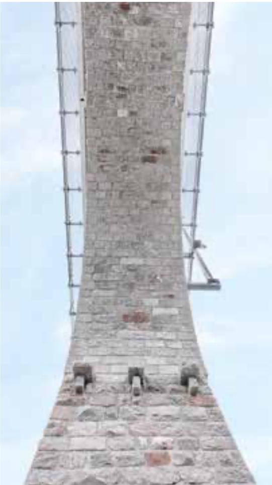
Der Creteo®Repair CC 194 M ermöglicht es, sowohl vertikale Flächen als auch Überkopfflächen effizient zu bearbeiten, was ihn zur perfekten Lösung für die Sanierung der Bogenunterseiten des Viadukts machte. Mit seiner hohen Festigkeit und Flexibilität gewährleistet er den langfristigen Schutz und die Stabilität des Viadukts unter den schwierigen klimatischen und mechanischen Bedingungen der Alpen.
