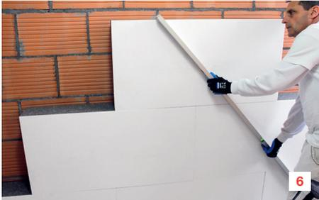
**6** Si nécessaire et ce après 10 à 15 minutes, les panneaux isolants peuvent être ajustés par pression avec une règle d'alignement.
