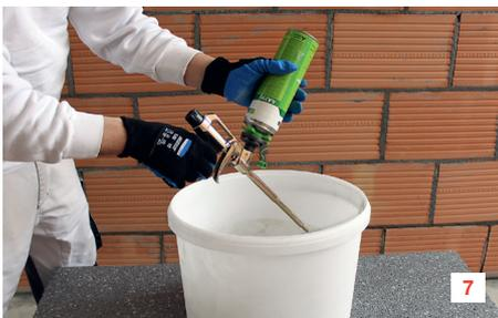
**7** Le système fermé par la vis de réglage permet de laisser mettre en place une nouvelle boîte de mousse de collage PU.
