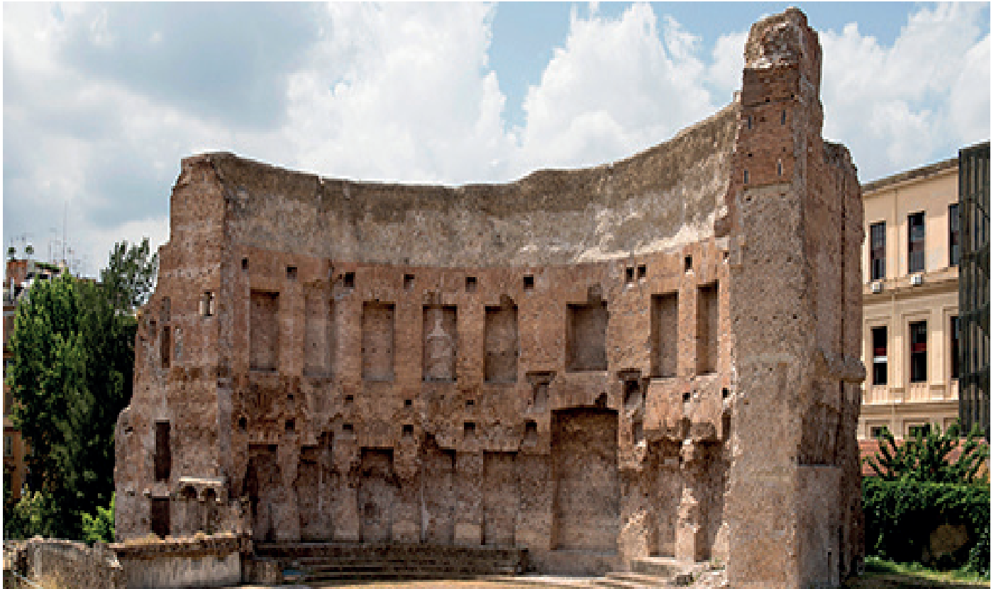
Sistemi di risanamento e restauro
