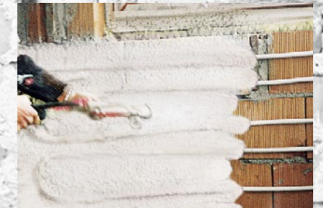
Wandheizungen verputzen 250 RENOPLUS
