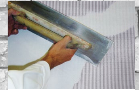
Armierungsgewebe einspachteln 250 RENOPLUS, 251 RENOSTAR, 252 RENODESIGN
