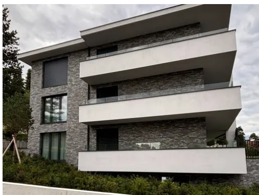
Auf der Garage wurde der Klinker direkt auf den Beton verklebt
