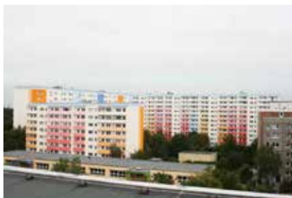
Totalansicht nach der Sanierung
