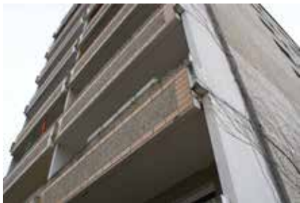
Vor der Sanierung Vorgehängte Betonplatten
