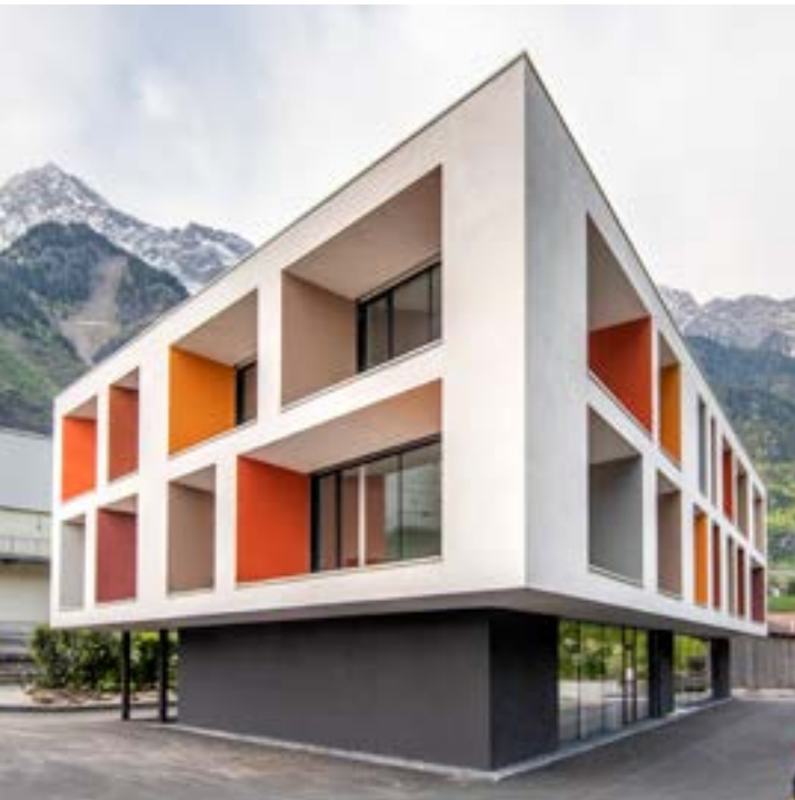
RÖFIX Zentrale Partschins, Italien
