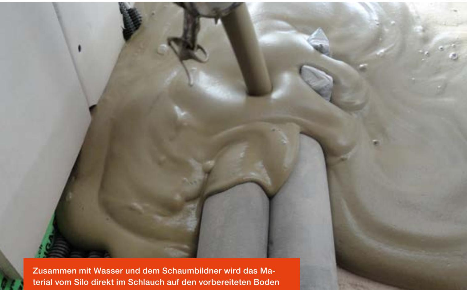
Zusammen mit Wasser und dem Schaumbildner wird das Material vom Silo direkt im Schlauch auf den vorbereiteten Boden aufgebracht. Das Tragen und Verteilen mit Schaufeln erübrigt sich, weil sich der RÖFIX POR® Schaummörtel mit seiner dünnen Konsistenz einfach und mühelos mit hoher Einbauleistung ausgleicht.
