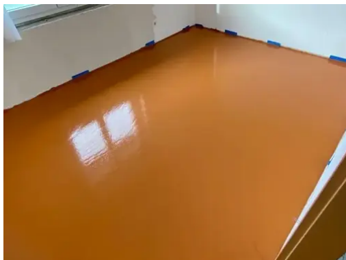
Chambre après installation terminée
