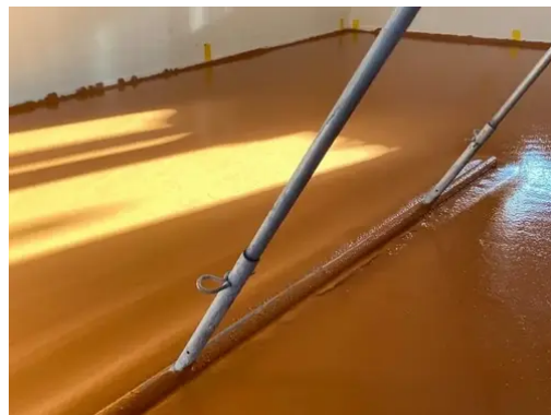
Chape fluide Application à la taloche
