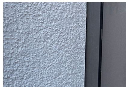
Fensteranschluss mit Anschlussprofil 3D Profil
