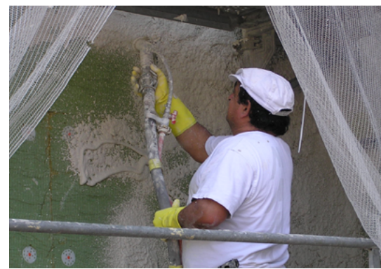
Objekt mit Steinwolle-Platten
