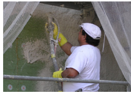
Objekt mit Steinwolle-Platten
