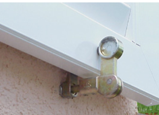
Montierter Klappladenrückhalter in Klobentragelement
