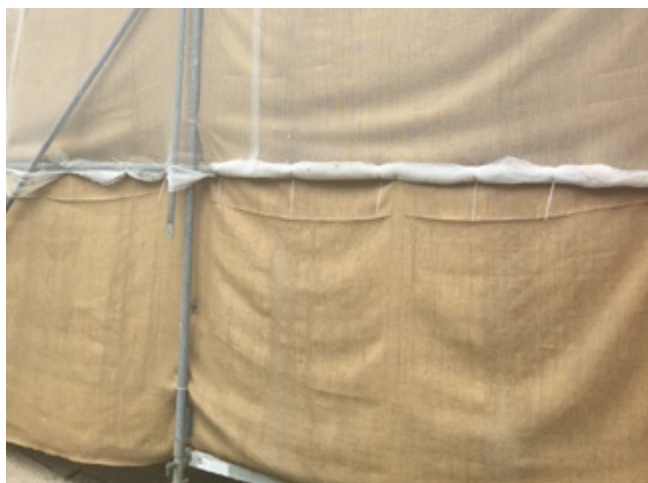
Gerüst mit Jutte abgehängt
