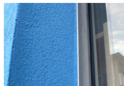
Fensteranschluss mit Anschlussprofil Ideal Plus in weiss oder antrazit
