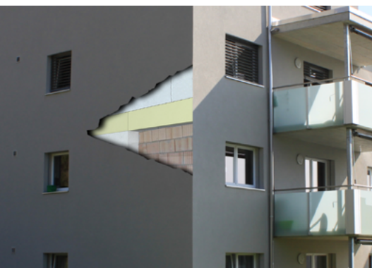
Eingebauter Brandriegel
