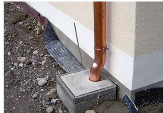
Sockelausführung mit Perimeter-Abdichtung und Noppenbahn
