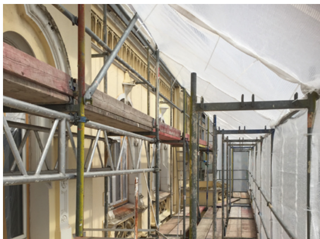
Gerüst mit Regenschutzdach
