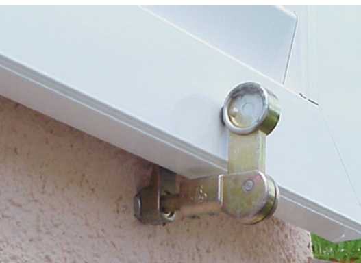
Montierter Klappladenrückhalter in Klobentragelement
