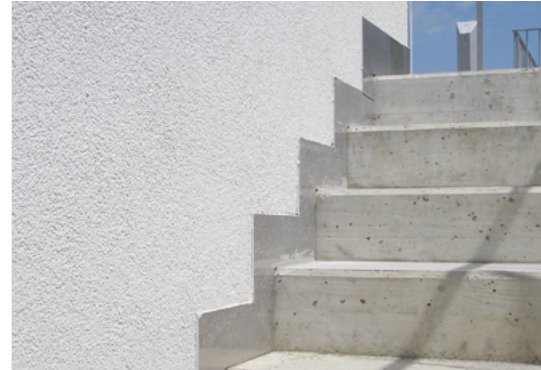
Fixit-Treppen-Sockelelement aus Blech
