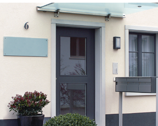
Beispiele für leichte Lasten an einer Aussendämmung
