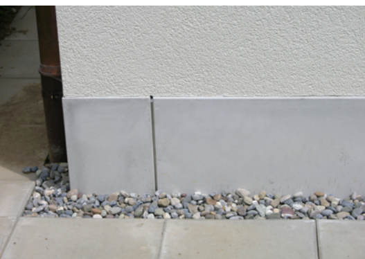
FIXITharm-Sockelelemente aus Glasfaserbeton sind bis zu einer Höhe von 1200 mm erhältlich.
