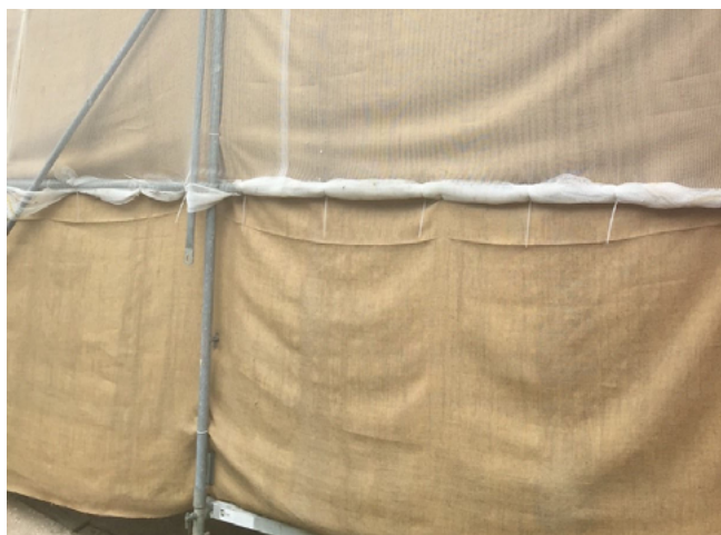
Gerüst mit Jutte abgehängt
