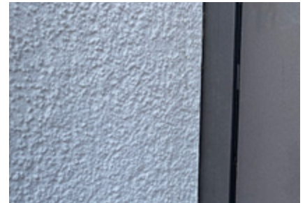
Fensteranschluss mit Anschlussprofil 3D Profil
