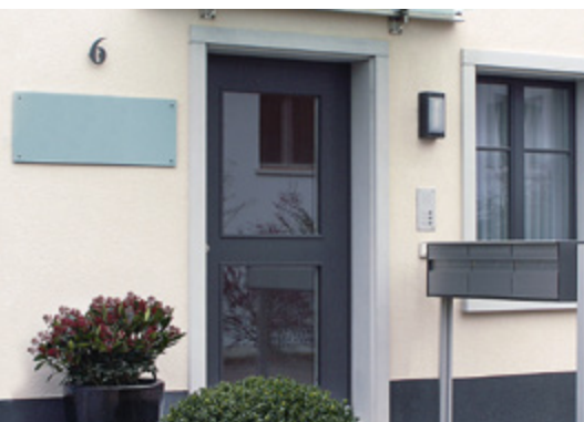
Beispiele für leichte Lasten an einer Aussendämmung
