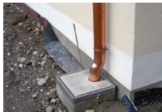
Sockelausführung mit Perimeter-Abdichtung und Noppenbahn
