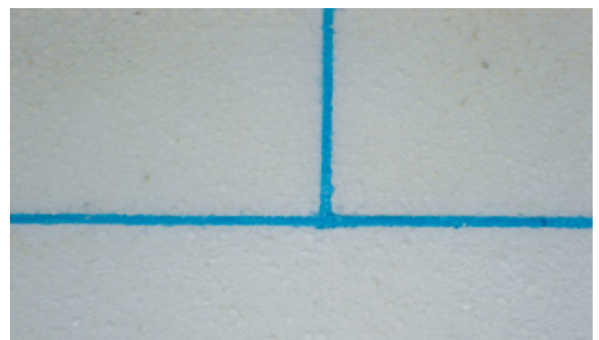
Offene Fugen verfüllt mit XPS- oder EPS-Hartschaum-Keilen
