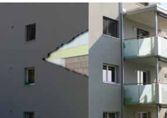
Eingebauter Brandriegel
