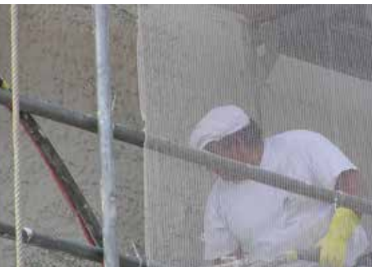
Einsatz von Fassadennetzen zum Schutz vor direkter Sonneneinstrahlung
