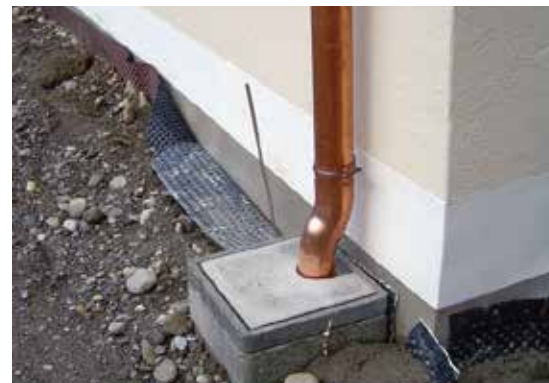
Sockelausführung mit Perimeter-Abdichtung und Noppenbahn
