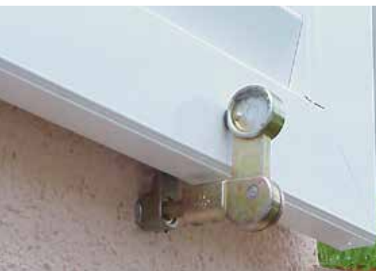
Montierter Klapppladenrückhalter in Klobentrageelement
