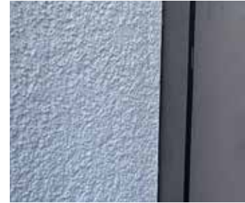
Fensteranschluss mit Anschlussprofil 3D Profi
