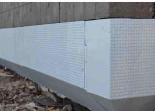
EPS 033 Sockelplatte 30, 45° geschnitten zur einfacheren Beschichtung des Sockels
