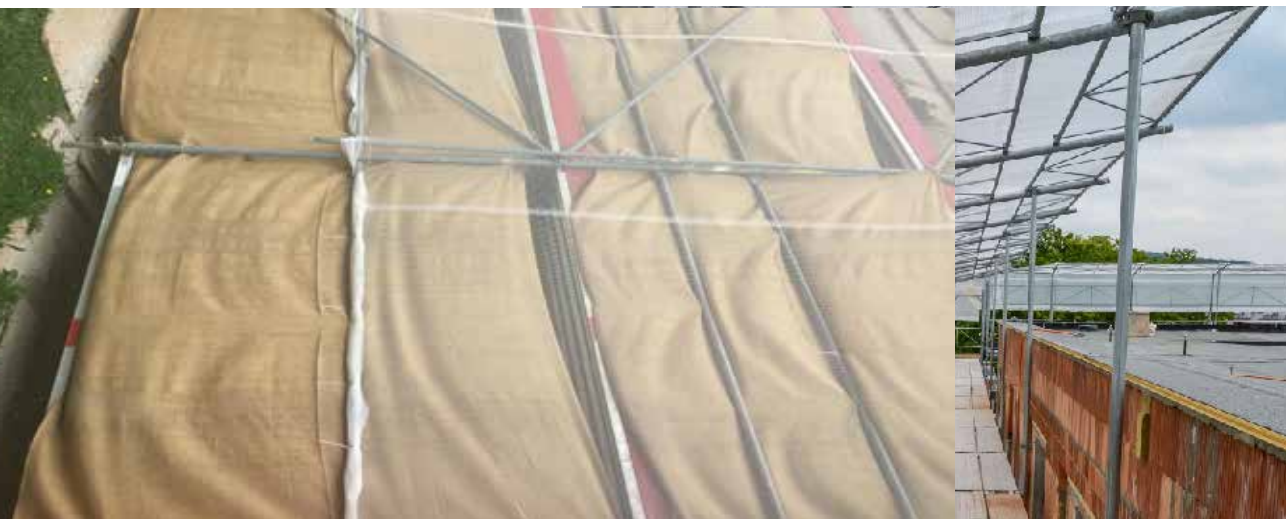
Gerüst mit Jutte abgehängt
