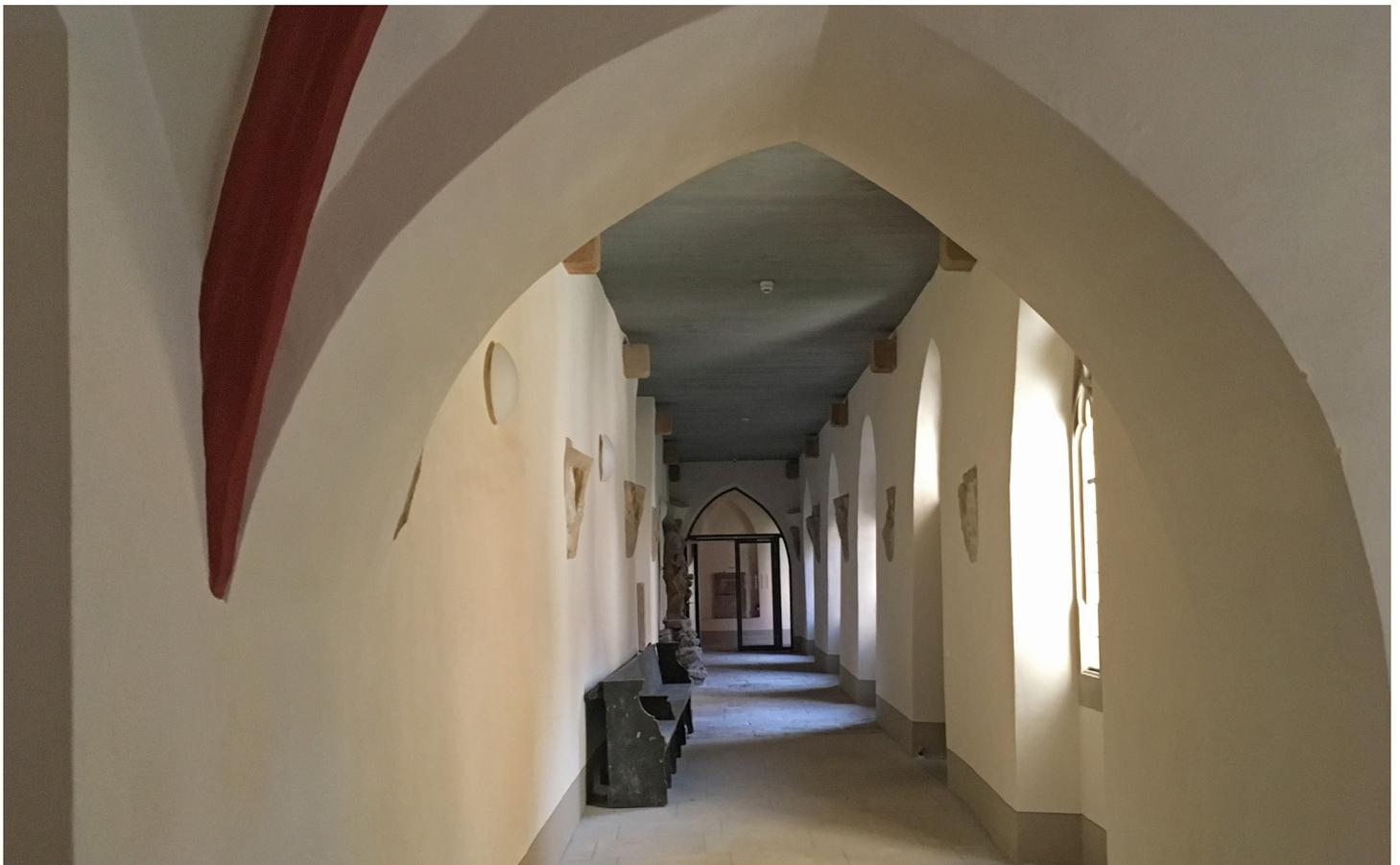
Der Innenbereich der heutigen Konzertkirche wurde mit dem **Hochleistungsdämmputz HASIT FIXIT 222** im Bereich der Faschen und im Kreuzgang sowie mit dem **Trasskalkputz HASIT 670** saniert.
