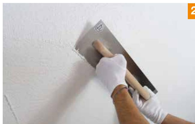
2. Après séchage, recouvrir l'enduit de base avec Fixit 740 Si 0,7 mm et lisser sans laisser de traces. Si nécessaire, poncer au préalable les traces de truelle laissées par l'enduit de base.
