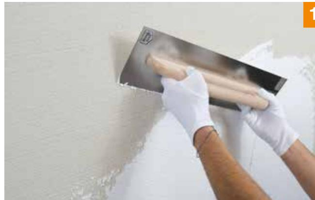
1. Appliquer la couche d'apprêt Fixit 740 Si 1,5 mm ribé plein sur l'armature jusqu'à obtenir une épaisseur de grain, puis lisser sans laisser de traces.
