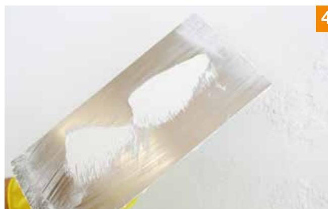
4. Le support doit être complètement sec. Appliquer de petites couches de Fixit 740 Si 0,7 mm à l'aide d'une truelle en acier inoxydable, les presser contre le mur et les étaler dans toutes les directions. La structure de l'écorce est largement influencée par la taille et l'espacement des couches.
