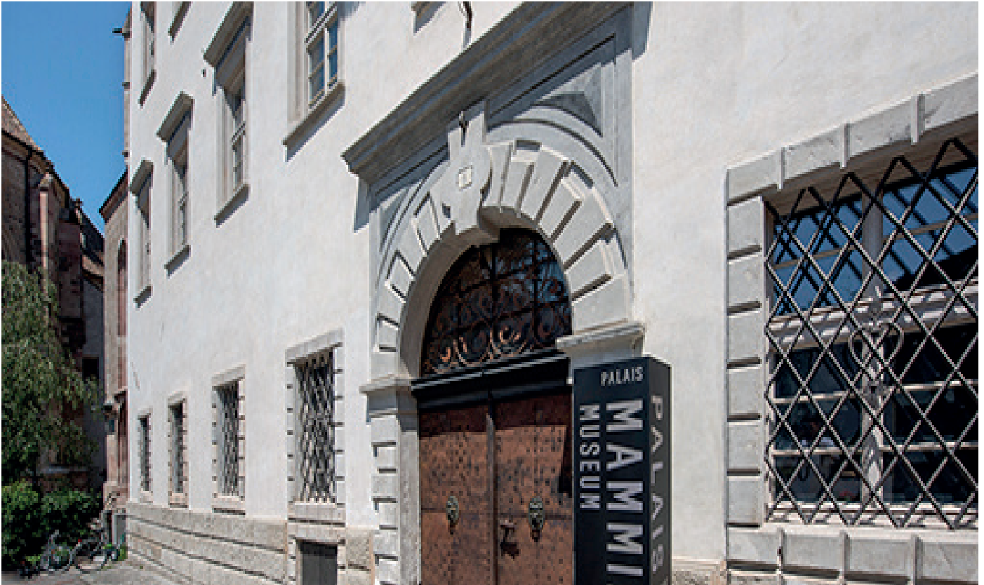
Sistemi di risanamento e restauro
