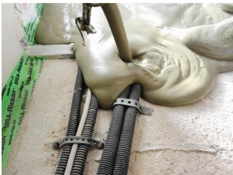
Aufgrund seiner fließfähigen Konsistenz verfüllt der Hasit POR® auch kleinste Ritzen. Rohre und Leitungen werden somit normengerecht fest und formschlüssig gesichert.
