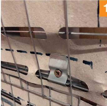
**1.** Befestigung mit SBS und Holzbauschrauben 45 mm
