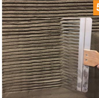
**5.** Grundputz 1. Lage nach dem Ansteifen mit Putzkamm aufreissen. Standzeit bei Kalkzementgrundputzen und Gipsputzen 1 mm pro Tag.
