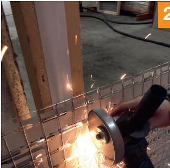
**2.** Kanten mit Trennscheibe die Verstärkungsdrähte trennen.
