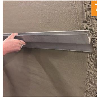
**7.** Mit der Latte sauber ausegalisieren und danach vollflächig kratzen. Standzeit pro Tag 1 mm.
