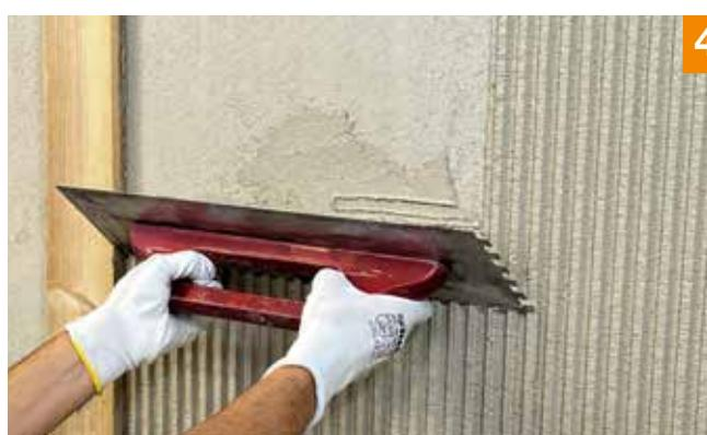
4. Égaliser le crépi décoratif Fixit 745 sur l'épaisseur grain et passer au peigne avec la truelle dentée 10x10 mm avec un angle de 45°.
