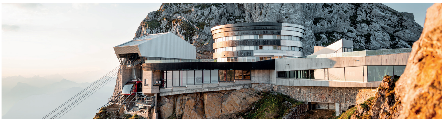
Extension du hall des départs « Station supérieure Pilatus Kulm », Suisse
