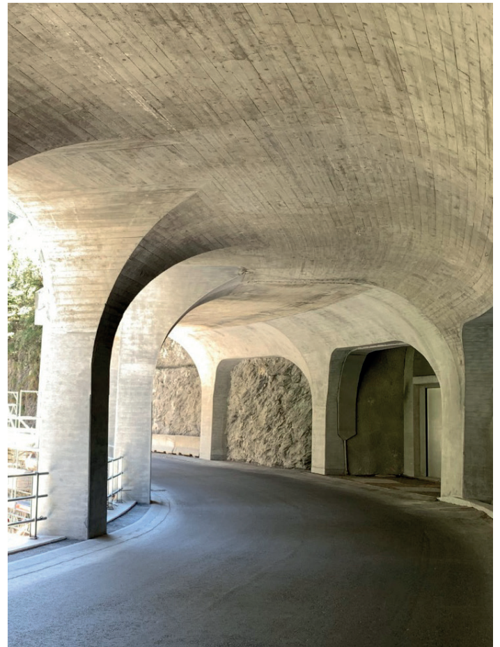
Remise en état de la « Galerie Viamala 1 », Suisse
