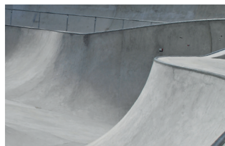
Béton et Travaux spéciaux de génie civil
