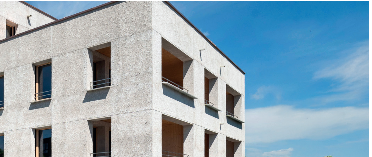
Construction durable et climatiquement neutre
