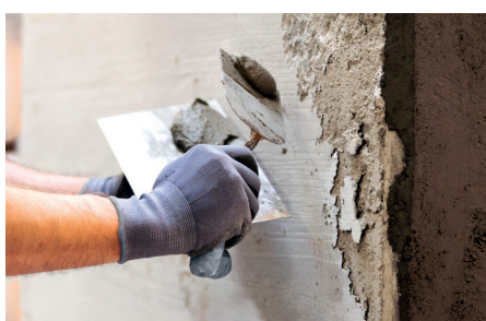
Assainissement, rénovation, restauration
