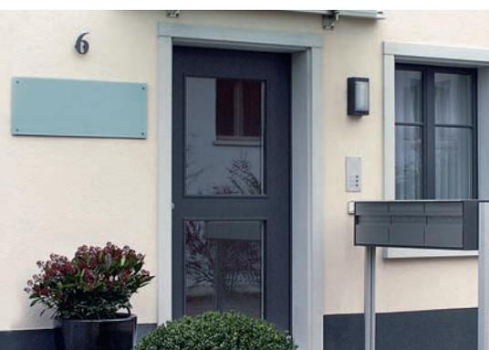
Beispiele für leichte Lasten an einer Aussendämmung
