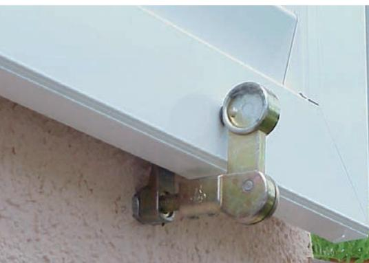
Montierter Klapppladenrückhalter in Klobentrageelement
