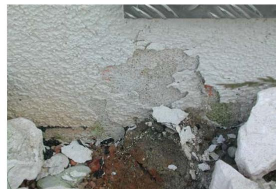
Nässe im Sockelbereich führt bei Frost-Einwirkung zu Putzschäden
