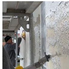
6 Auftragens des Oberputzes
