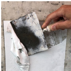
1 Prüfen des Untergrundes
