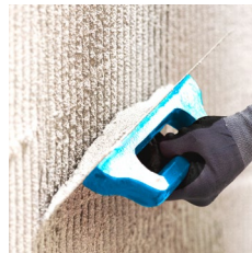
5 Einbetten des Armierungsgewebes mit Armierungsmörtel
