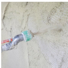
3 Aufbringen des Dämmputzes
