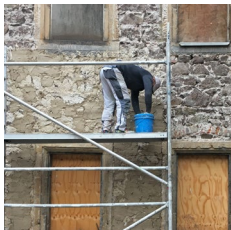
2 Evtl. vorbereitende Maßnahmen wie Vorspritz oder Aufbringen eines Putzträgers wie Schilfmatte oder Welnet.
