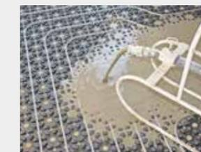
Unsere selbstnivellierenden Fließeströche sind als besonders emissionsarm eingestuft und die idealen Partner für Fußbodenheizungen.
