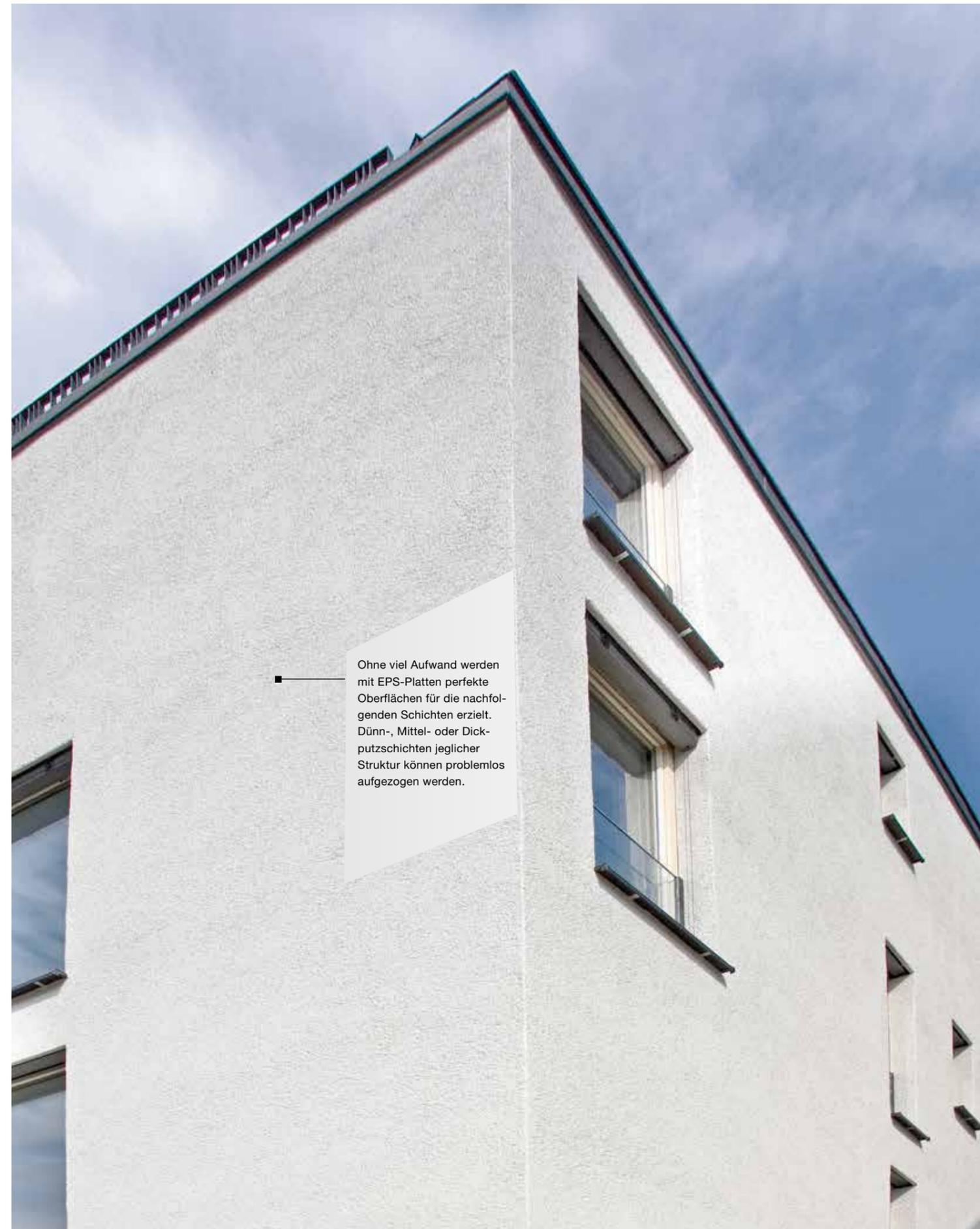
Ohne viel Aufwand werden mit EPS-Platten perfekte Oberflächen für die nachfolgenden Schichten erzielt. Dünn-, Mittel- oder Dickputzschichten jeglicher Struktur können problemlos aufgezogen werden.
