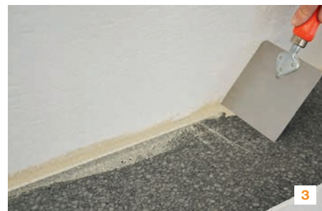
Kontrolle der Kleberkontaktfläche
