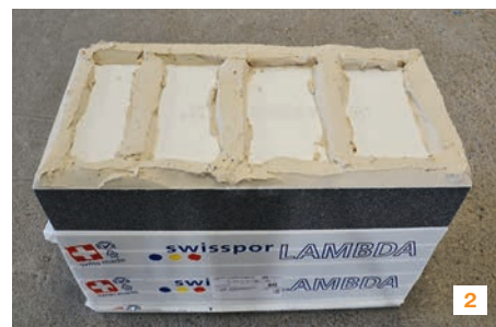
Kontrolle der Kleberkontaktfläche
