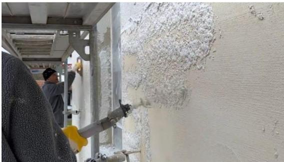
Durch den Einsatz eines Dämmputzes Hasit 840 CalceClima® Thermo konnte das Ziegelmauerwerk in seiner Stärke reduziert werden – ohne energetische Abstriche in Kauf nehmen zu müssen.
