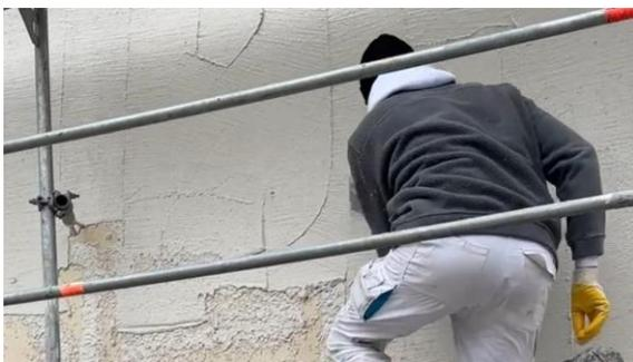
Alle eingesetzten Putze sind Kalkgebunden und überzeugen mit einer hohen Dampfdiffusionsoffenheit.
