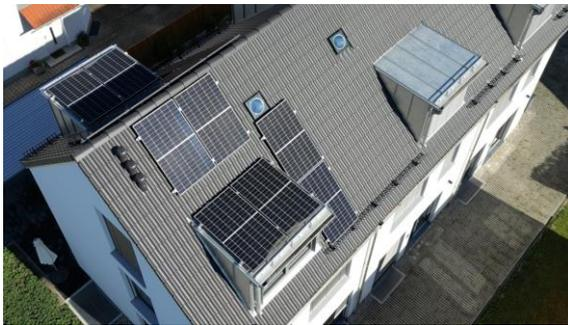
Das Gebäude erfüllt die Energieeffizienzklasse A+. Die Luftwasserwärmepumpe wird über eine PV-Anlage mit Strom versorgt.
