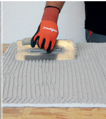
Nanos lepila po postopku buttering-floating (lepilo na podlagi in na plošči)
