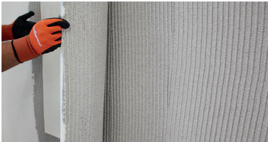
Lepljenje toplotnoizolacijskih plošč po postopku buttering-floating
