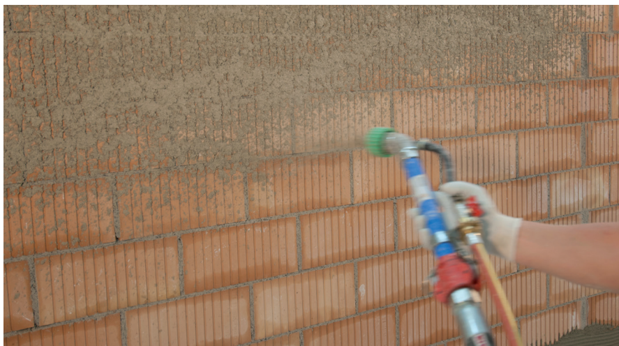
Priprava podlage z običajnim strojem za omete
