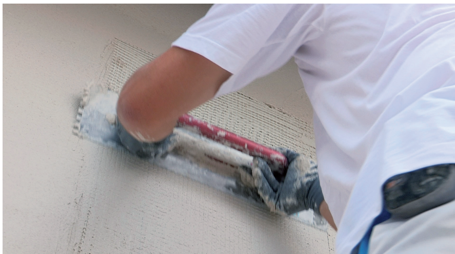
Vgradnja mrežice z malto za armiranje
