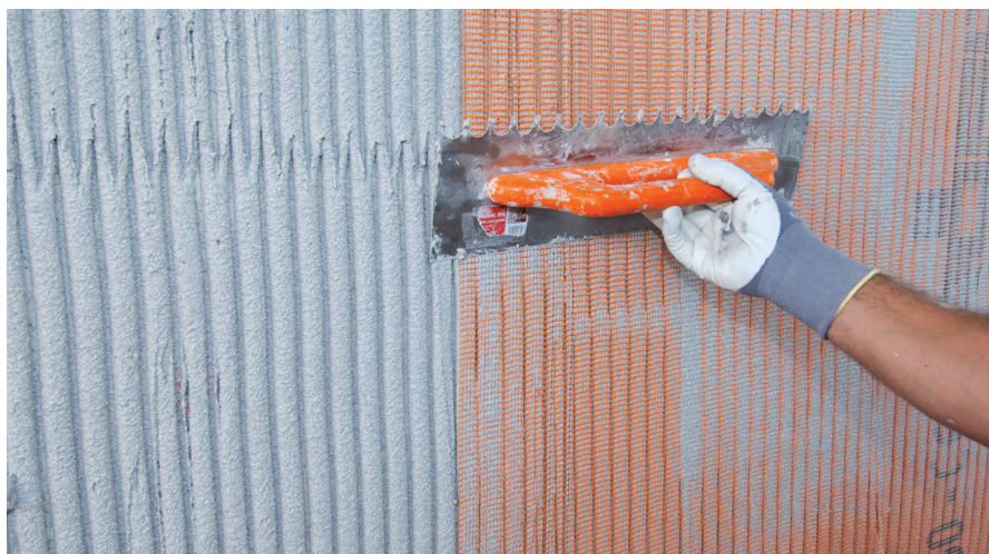
Izdelava armiranega osnovnega ometa
