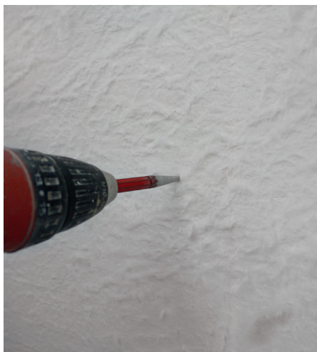
Predpriprava lukenj za sidra z luknjačem in vrtanje z vrtnikom
