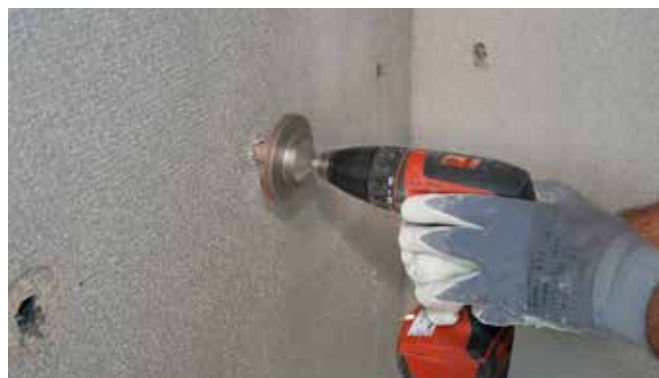
Svrdlom od 8 mm pa rupu za pričvrsnice proširiti svrdlom br. 28
