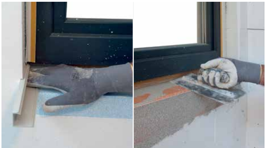
Bagheta de tencuire solbanc RÖFIX SOL-PAD se va lipi cu RÖFIX MS POLYMER, apoi zona de montare a pervazului se va umple prin șpăcluire cu RÖFIX OPTIFLEX® 1K sau 2K.
