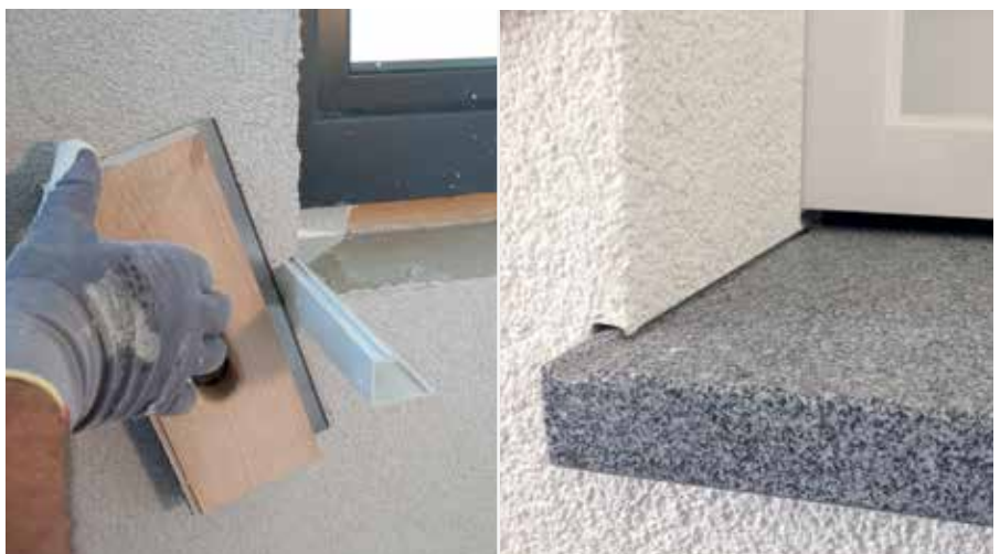
Cu ajutorul unelei RÖFIX SOL-PAD-Tool se taie bagheta de tencuire RÖFIX SOL-PAD cu un surplus de 2 mm și se montează pervazul.
