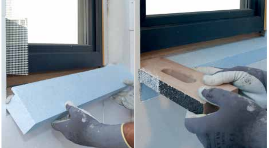
Se va lipi RÖFIX SOL-PAD Base și se șlefuieste nutul pentru introducerea profilului.
