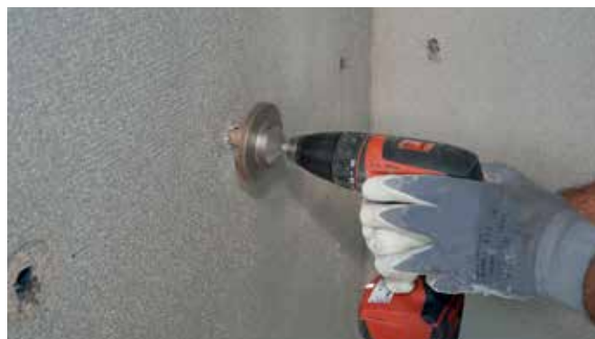
Gaura pentru diblu de 8 mm se lărgiște cu o freză de tencuială de 18 mm.
