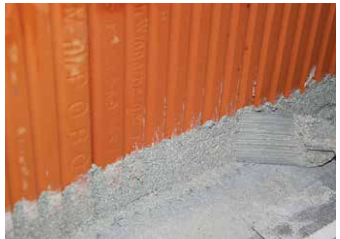
Rostul de adeziune va fi netezit cu mortar adeziv în mod linear (min. la fiecare al treilea strat).
