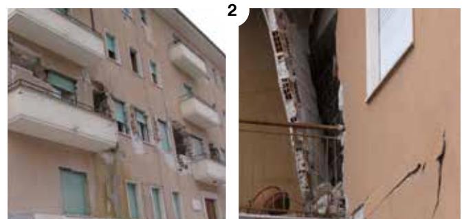
Razdvajanje vanjskog ruba nenosivog zida unutar armirano-betonskih okvirnih konstrukcija
