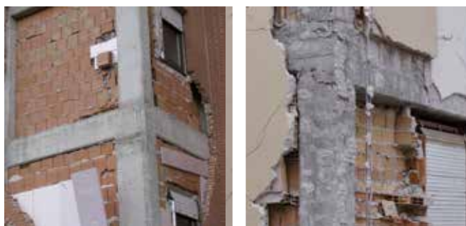
Razdvajanje vanjskog ruba armirano-betonske okvirne konstrukcije
