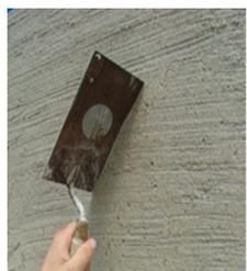
Nachdem der Grundputz hart geworden ist, muss der Untergrund vollflächig gekratzt werden, damit keine Sinterschichten entstehen.
