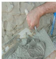
Am nächsten Tag kann mit dem Grundputz weitergearbeitet werden. Dieser wird von Hand angeworfen oder maschinell aufgetragen.
