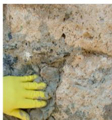
Die Löcher werden mit erdfeuchter Konsistenz von Hand gestopft.
