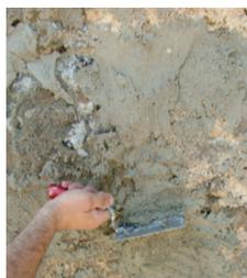
Sobald der Mörtel am Untergrund angetrocknet ist, muss der Stopfmörtel gekratzt werden.
