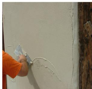
Der Deckputz wird aufgezogen und kann geglättet, abgerieben oder mit der Bürste bearbeitet werden.
