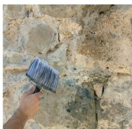
Das Mauerwerk muss vor dem Stopfen vorgeätzt werden.
