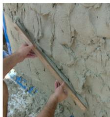
Anschliessend wird der Grundputz mit der Holzlatte plangezogen.
