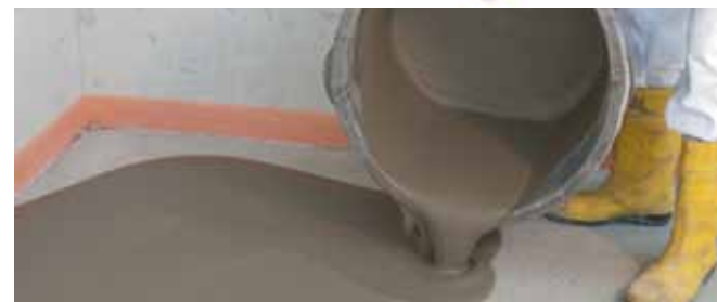
Izlijevanje mase za niveliranje podova
