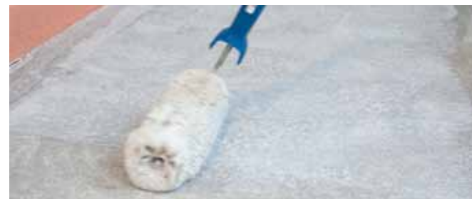
Nanošenje predpremaza
