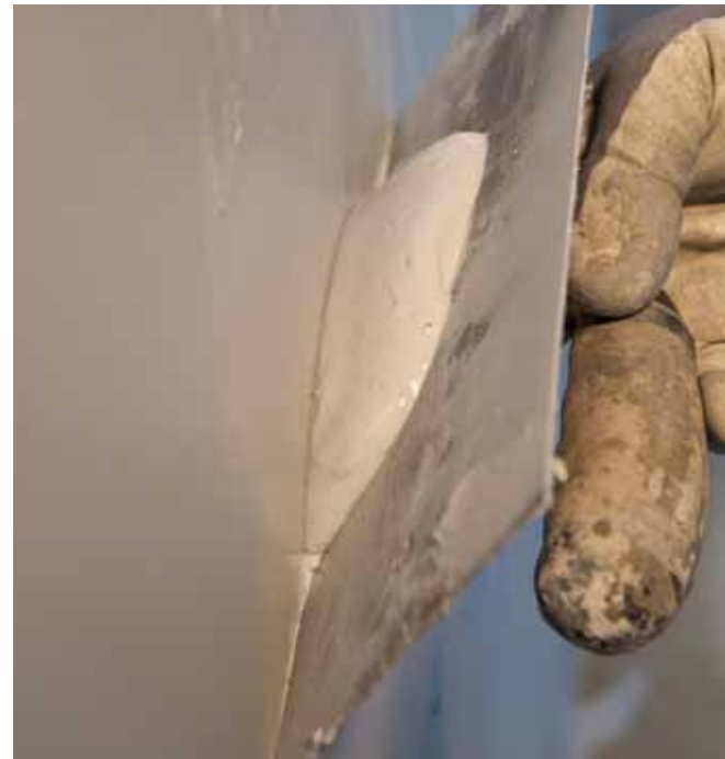
Nanošenje mase za hidroizolaciju
