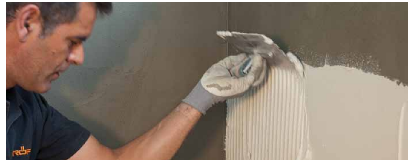
Nanošenje ljepila za keramiku
